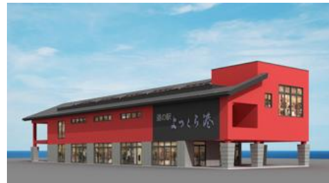
完成後は緊急時の一時的な避難場所、災害支援拠点としても機能します
