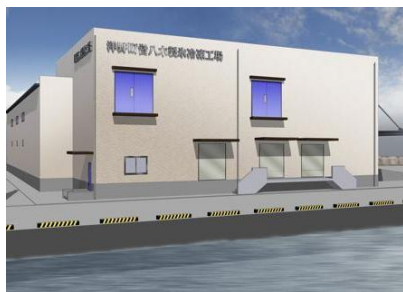
【新施設】 鉄筋コンクリート造り(一部鉄骨造り、一部2階建て) 延床面積：1,516.27㎡ 製氷能力：71.8t／日 貯氷能力：317t
