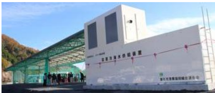
新装置は殺菌冷海水を30t供給でき、大型漁船の水揚げにも対応可能
