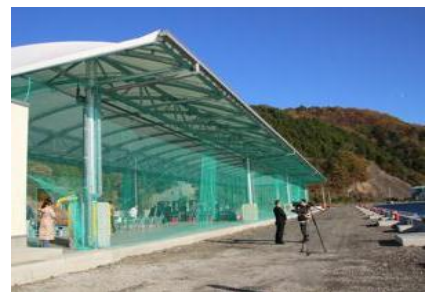
新浜町魚市場の一部竣工も同時に祝いました
