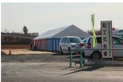
あぶくま高原道路の矢吹中央ICから400m、東北自動車道の矢吹ICから2kmと好アクセスな場所に建設します
