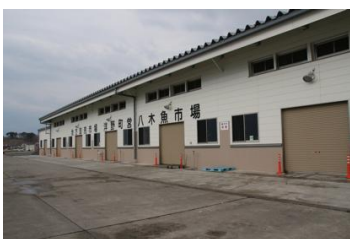
再建した町営魚市場
