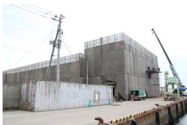
建設途中の施設
